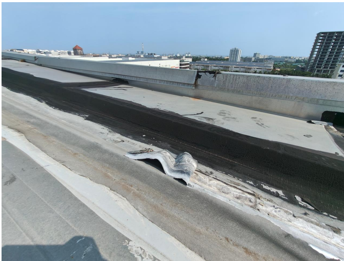
图 5-4 山墙墙面现场实际情况
