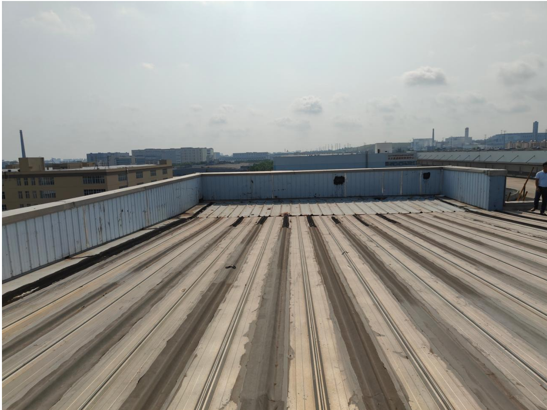
图 5-11 加强型屋面板现场实际情况
