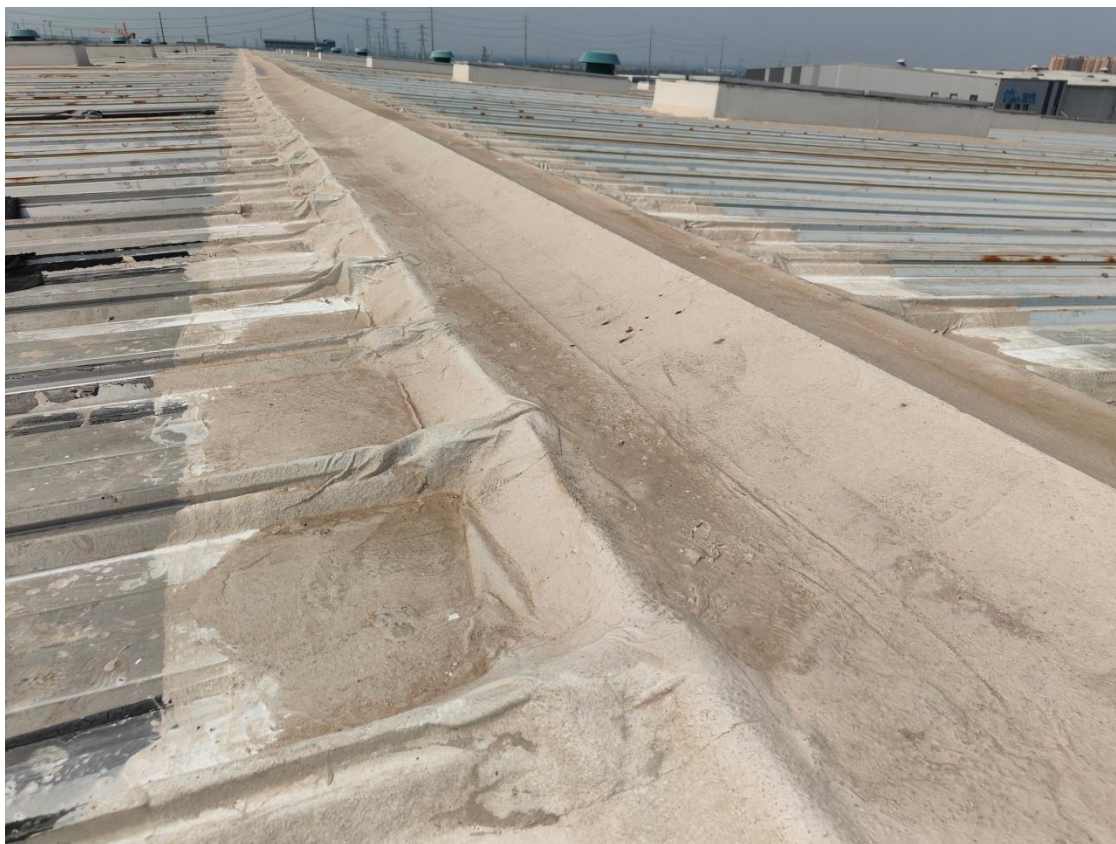
图 5-6 屋脊原节点做法及现场实际情况
